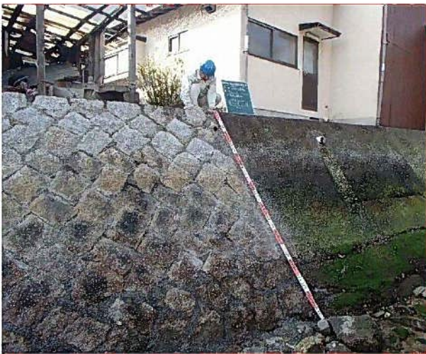
5.出来形検収状況
