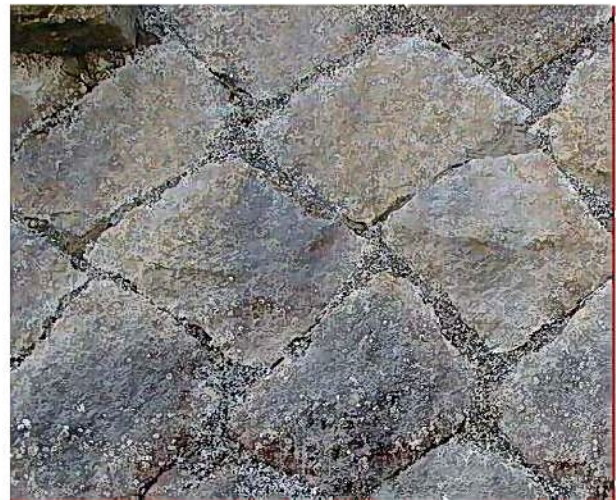
6.充填完了状況(近景)
