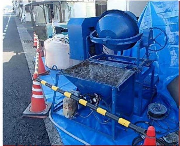
2.プラント設置状況
