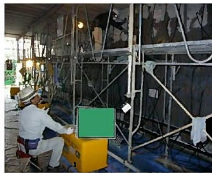
浸透拡散型亜硝酸リチウム プロコン40 注入状況
