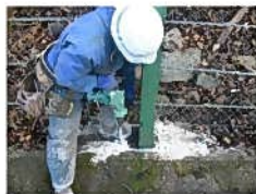
写真1：支柱基部アンカー削孔
