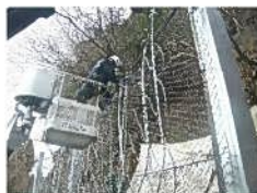
写真3：ワイヤネット設置
