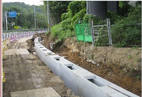
ハレーサルトVS側溝 施工実績
