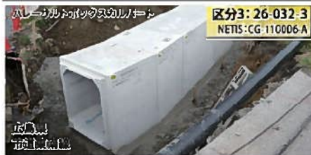
副題 セメント60%と細骨材100%を高炉スラグに置き換えたコンクリートを用いて製造する低炭素型高耐久プレキャストボックスカルバート
