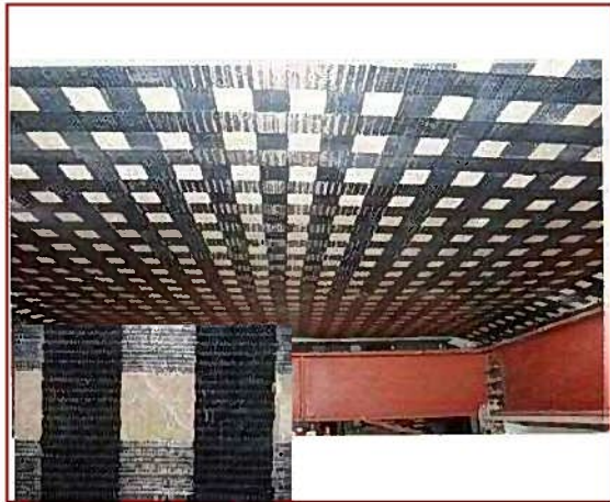
完成写真とひび割れの視認性
