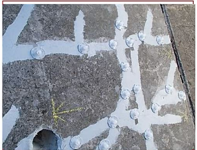
CRBインジェクターの台座取り付け
