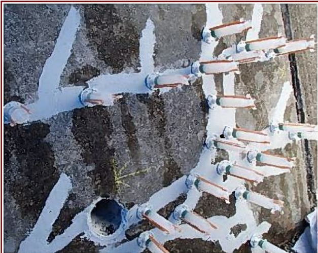
亜硝酸リチウムの注入
