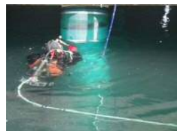
写真2:PC樹脂型枠設置
