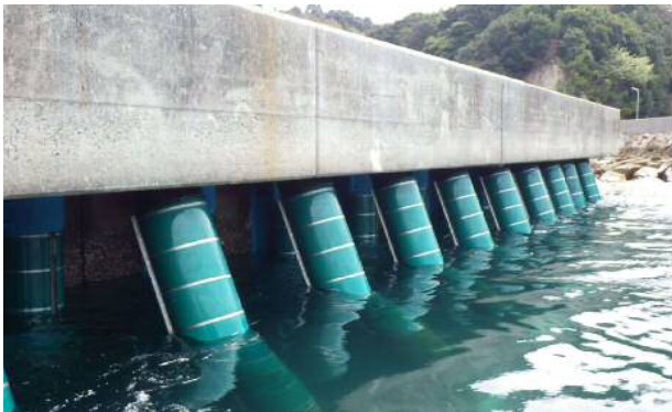
SPC工法完成写真(豊島漁港・斎島)
