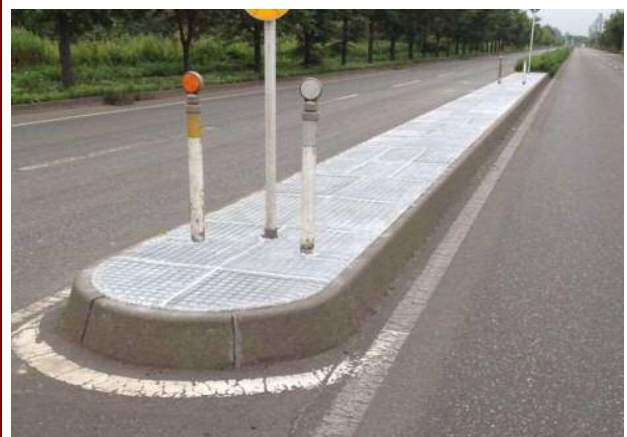
中央分離帯施工例
