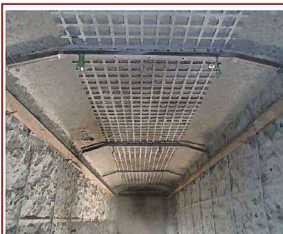
はつり、防錆処理完了
