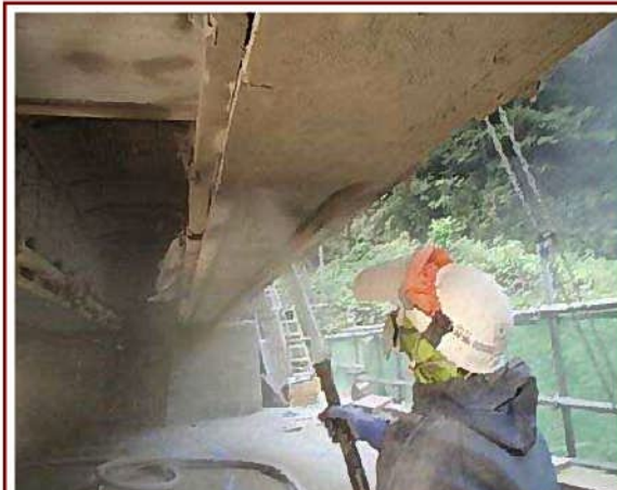
乾式吹付施工状況
