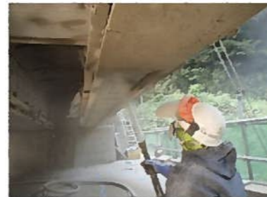
写真2：乾式吹付状況
