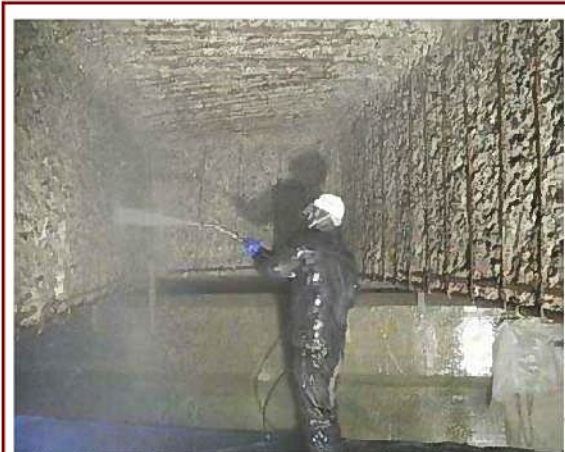
下地処理(高圧洗浄)状況
