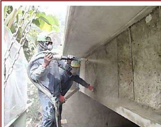
乾式吹付施工状況
