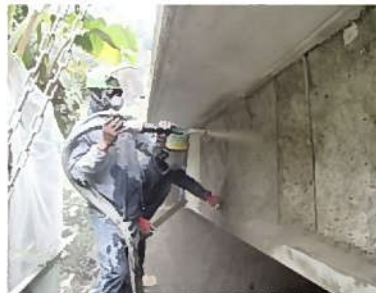
写真3：乾式吹付状況
