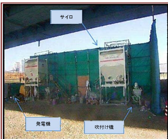
乾式吹付けプラント設置状況
