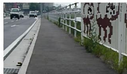
写真2：国道201号左側は雑草防止工法 右側は重力式擁壁（防草対策なし）
