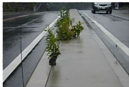
写真3：中央分離帯施工後1年経過
