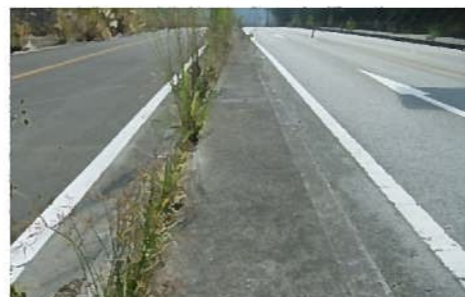
写真4：中央分離帯施工後8年経過
