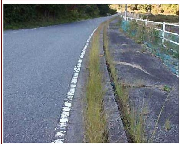
雑草繁茂状況
