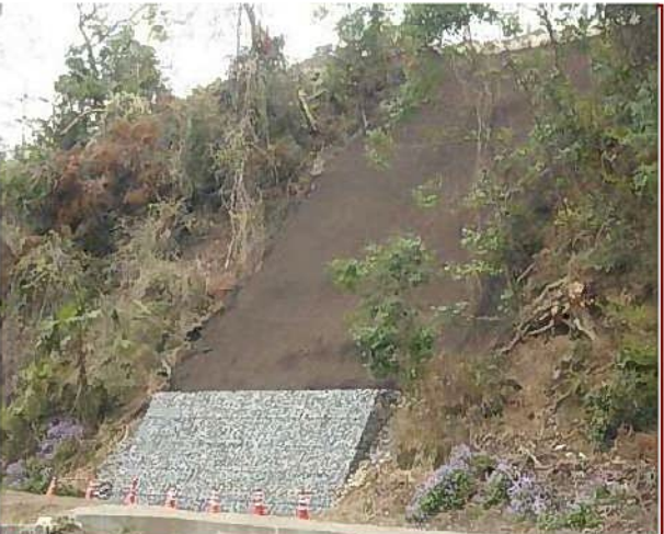
実績写真 栃木県
