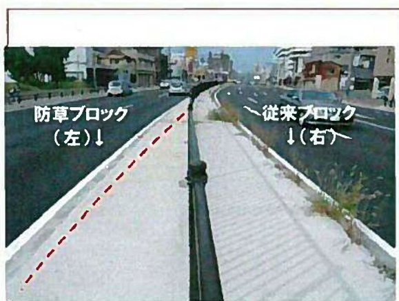
完成後約1年経過
