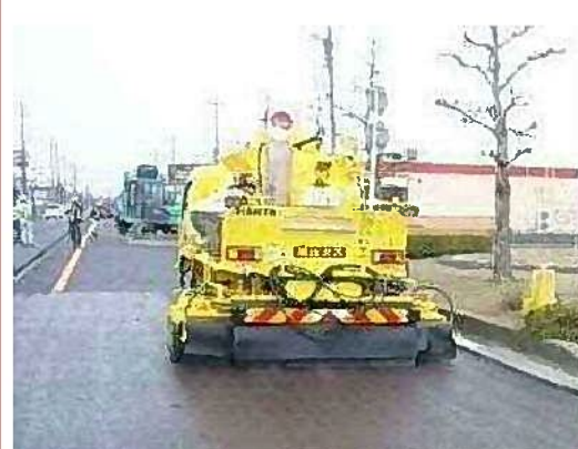
スーパータックゾール散布状況
