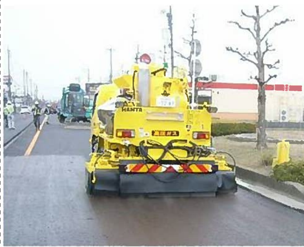
写真1：乳剤散布状況
