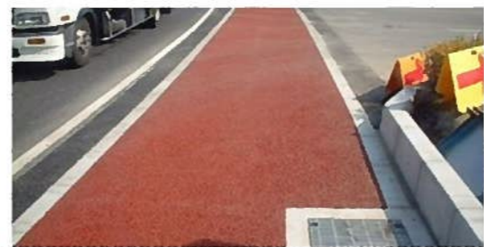
写真2：CSファルトレッド使用 透水性歩道
