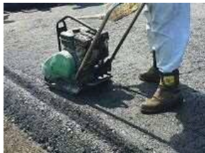
写真3：転圧機械(プレート)使用例
