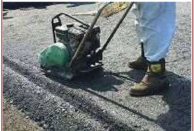
転圧機械(プレート)使用例
