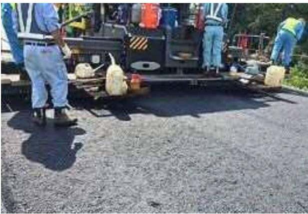
転圧機械(フィニッシャ)使用例
