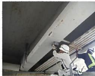
写真1：鉄筋探査による位置決定
