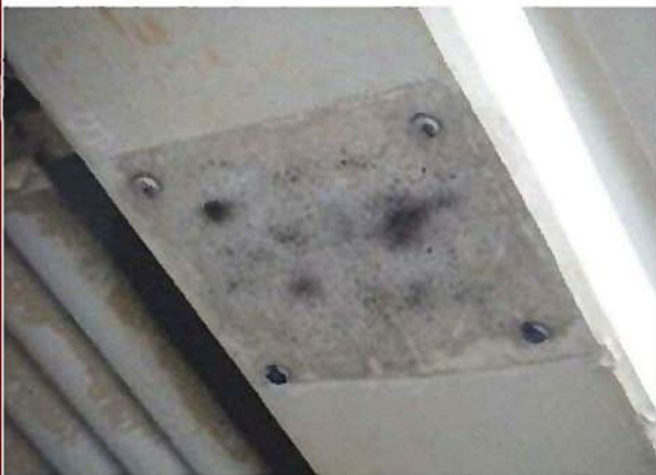
作業手順(3)固定治具の設置
