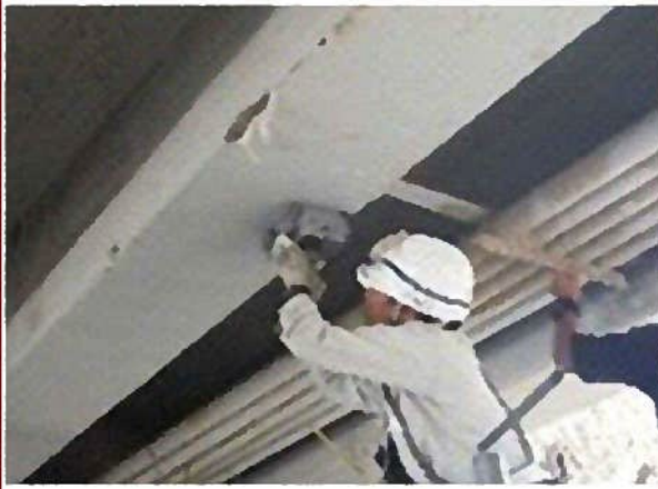
作業手順(1)鉄筋探査
