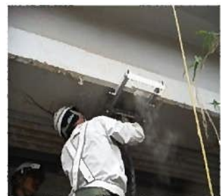
写真3：スリット切削
